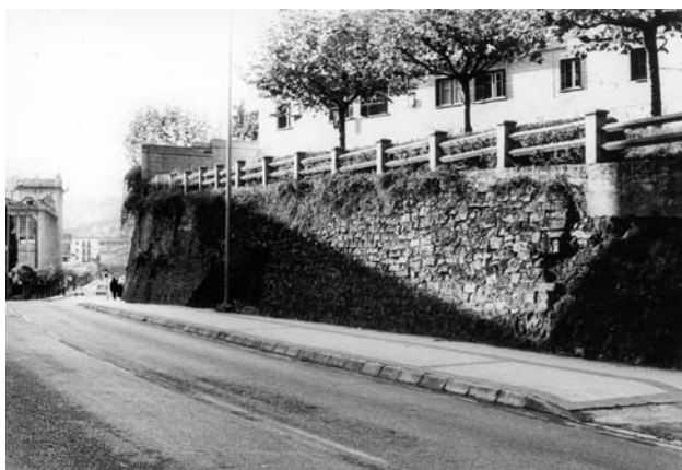
Ley de Fugas, les mataron al lado de esta pared.
