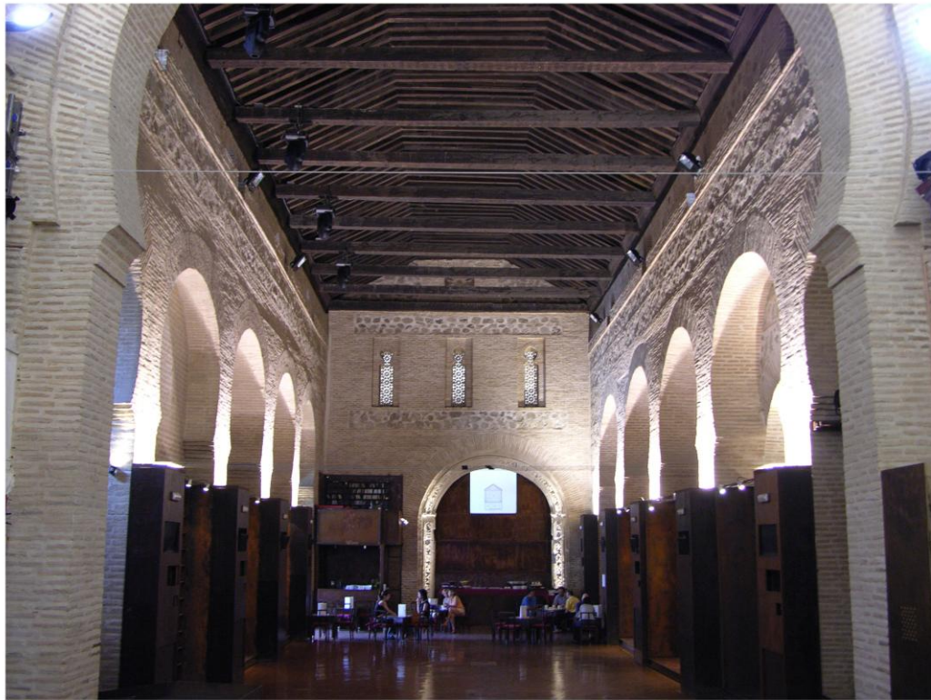
SALA PRINCIPAL. Orientación hacia el arco gótico (al fondo izqda. puerta acceso).
